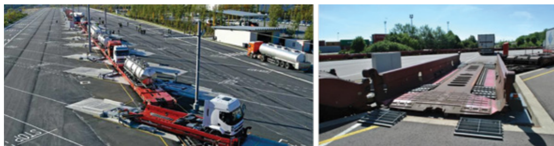
图15. 使用“Modalohr”技术的场站。
